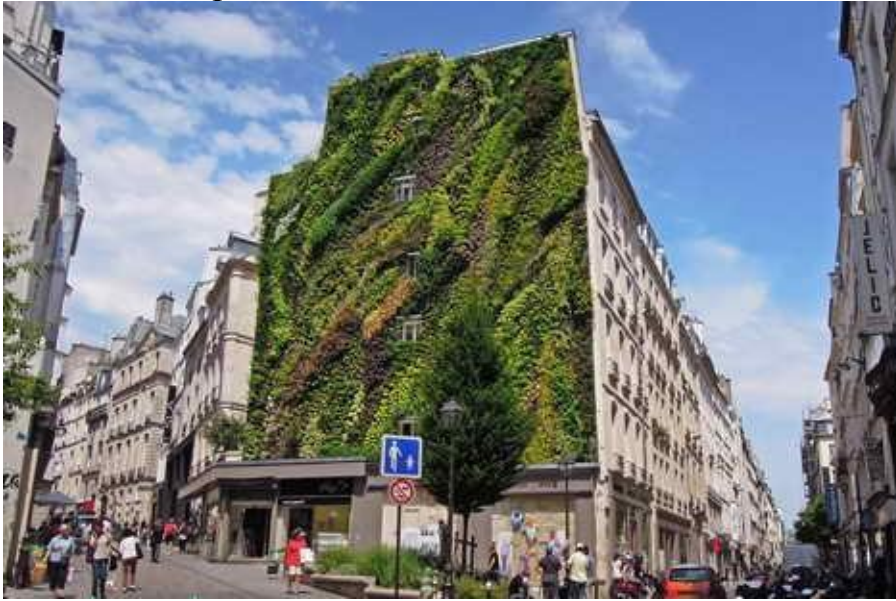
Малюнок 4. Охолодження стіни будинку вертикальною клумбою
